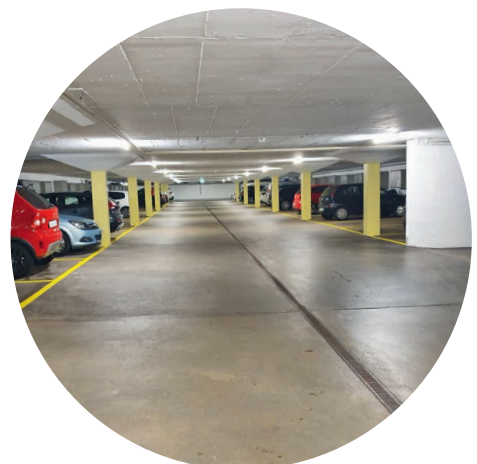
Garage nach Sanierung
