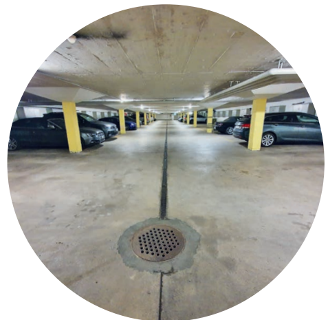
Garage vor Sanierung
